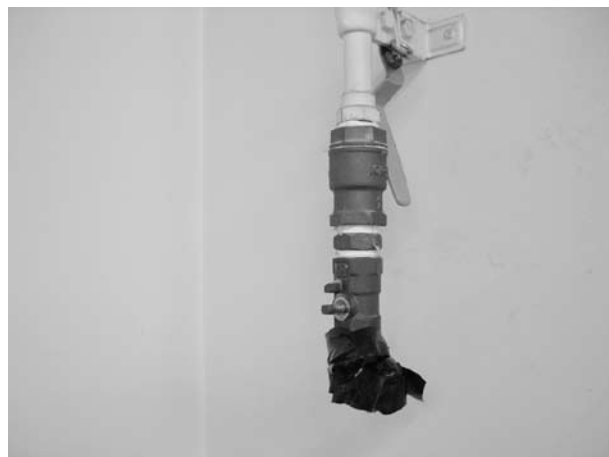
図7．バルブハンドル取りはずし後
