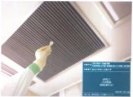
換気口 汚染検査 (間接測定法)
