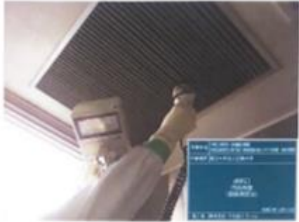
換気口 汚染検査 (直接測定法)
