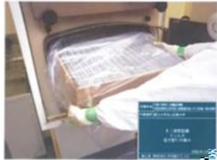
換気フィルタ 取り換え
