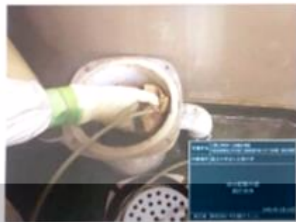
排水口 高圧洗浄
