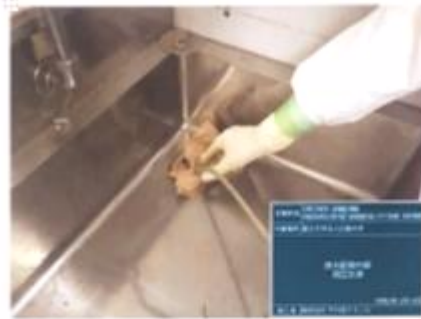
排水口 高圧洗浄
