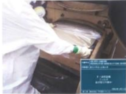
換気フィルタ 取り換え
